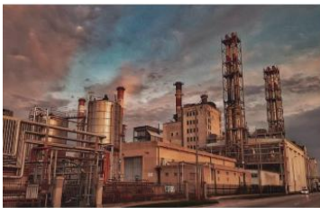
Central Térmica de Motores
